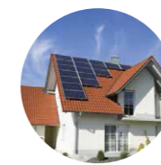
Điện mặt trời áp mái (Free - solar)
